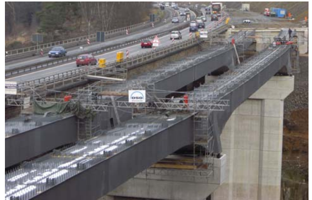
Bild 11: Verbundbrücke Einsiedelstein (BAB A1)
