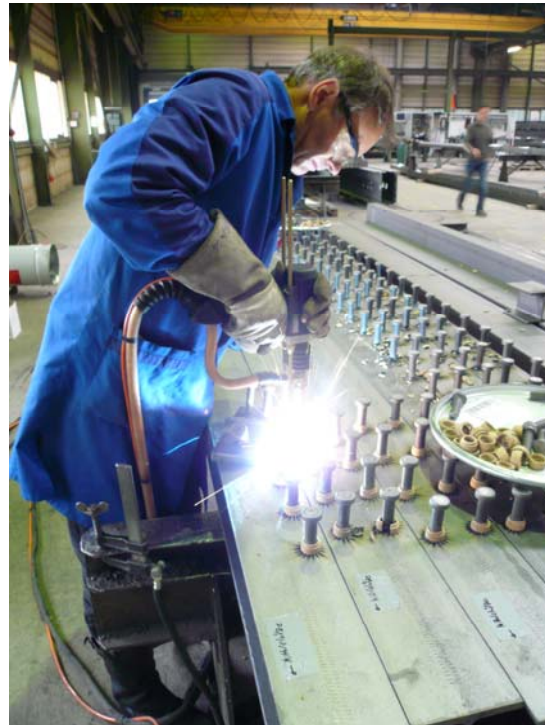
Bild 4: Bolzenschweißen in der Serienfertigung von Verbundträgern
