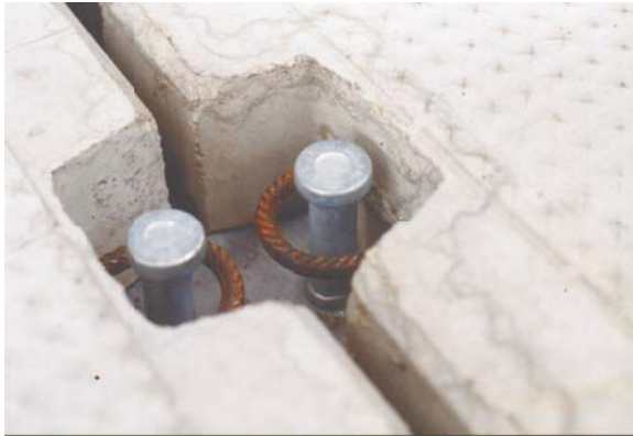
Bild 5: Fuge zwischen zwei Deckenplatten eines Parkdecks vor dem Vergießen
