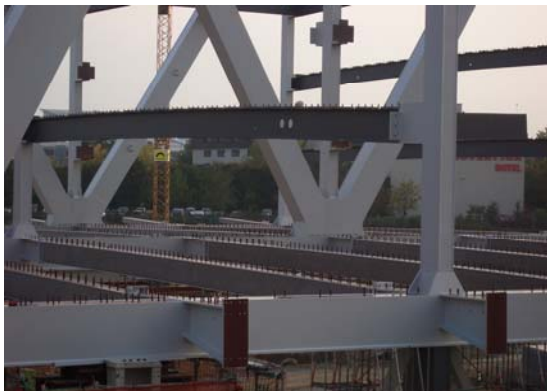
Bilder 3a und 3b: Weitgespannte Verbundträger im Parkhausbau
