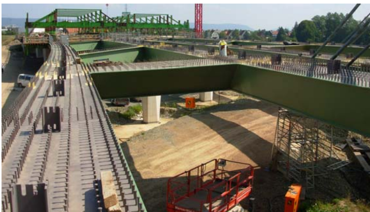
Bild 12: Verbundbrücke bei Bad Oeynhausen
